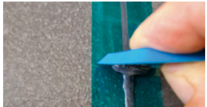
Entfernen des überschüssigen Materials
