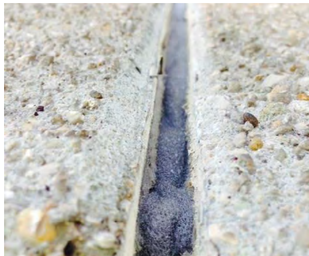
Mit Rundschnur hinterfüllte Fuge
